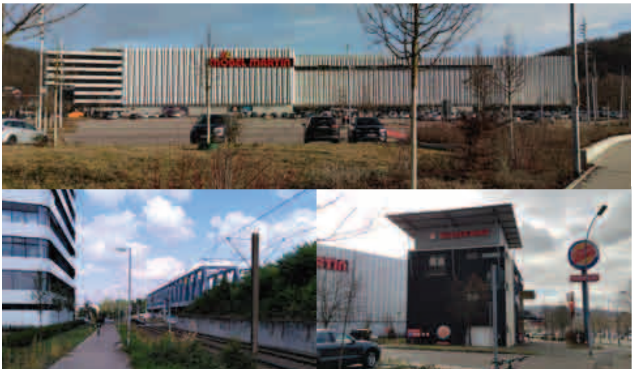
Abb. 22 : Blick von Süden auf die prägende Fassade / Fußweg zwischen Möbel Martin und Bahndamm in Richtung Bahnbrücke bzw. Juris Neubau / Neubau Burger King an der Ostspange
